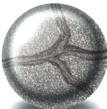
クラックカット シール工法
