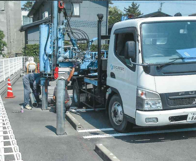
舗装面に基礎鋼管杭を直接打ち込みます。
