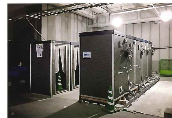
高層ビル建設現場にて
