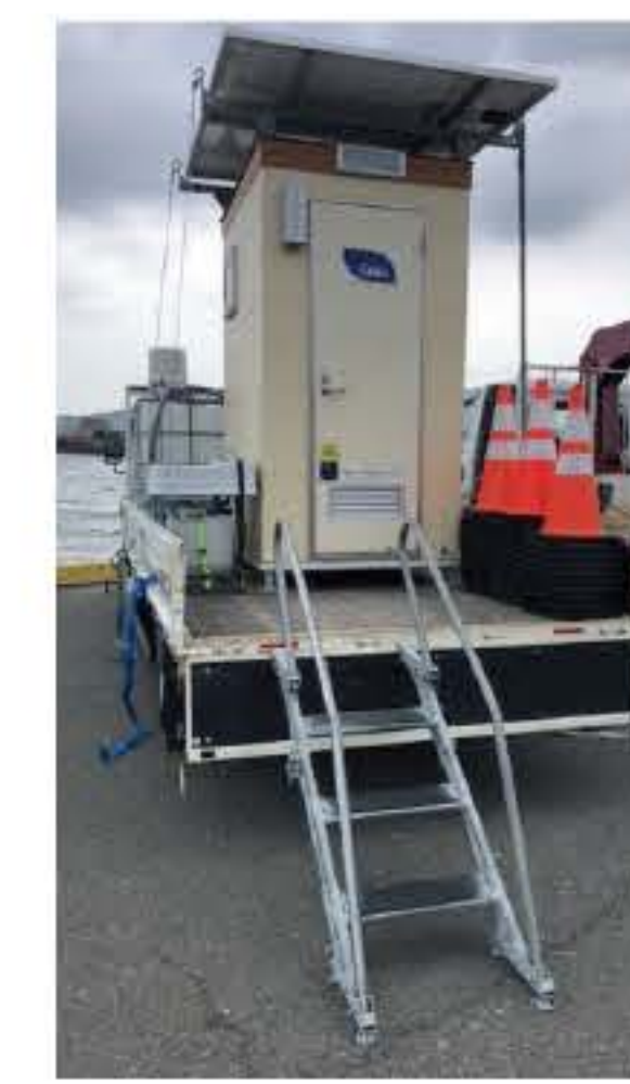
防波堤改良工事
