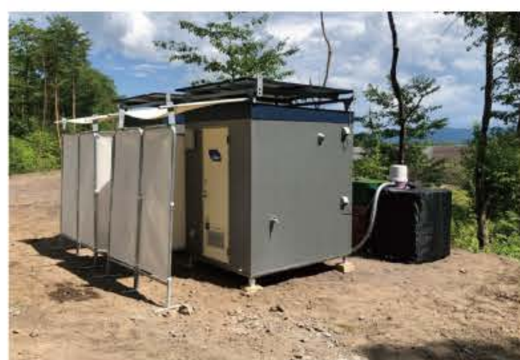
長野県 [工事現場 / WII型]
